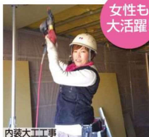
内装大工工事
